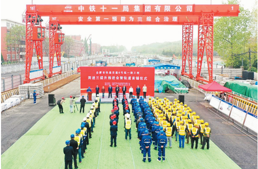
轨道首铺仪式
