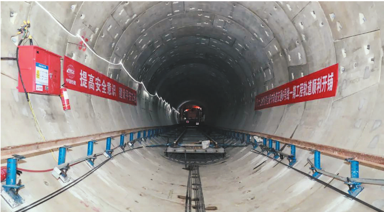
6号线一期工程正式进入铺轨阶段
