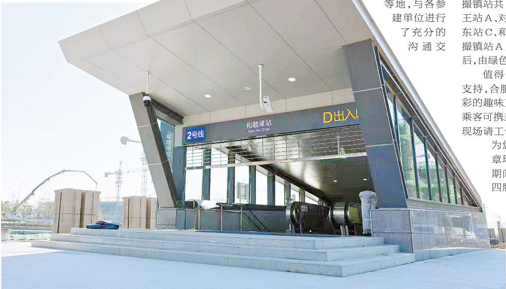
2号线东延线和睦湖站
