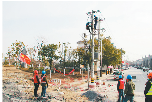
○确保道路拓宽改造工程顺利推进
