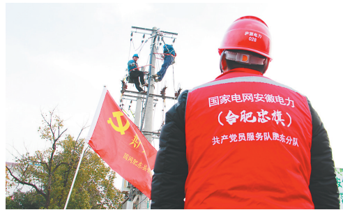
○拓宽杆线迁改进度
